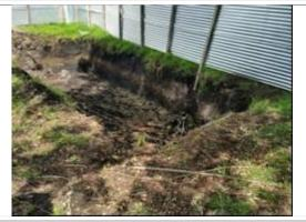
Foto No. 03. Zona de excavación para el sistema de tratamiento de aguas residuales
