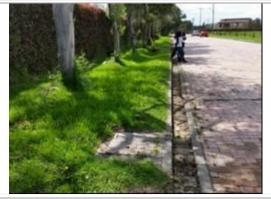
Foto No. 06. Evidencia de que el vallado de la Kr 77 se encuentra tapado y no garantiza el respectivo drenaje hidráulico.
